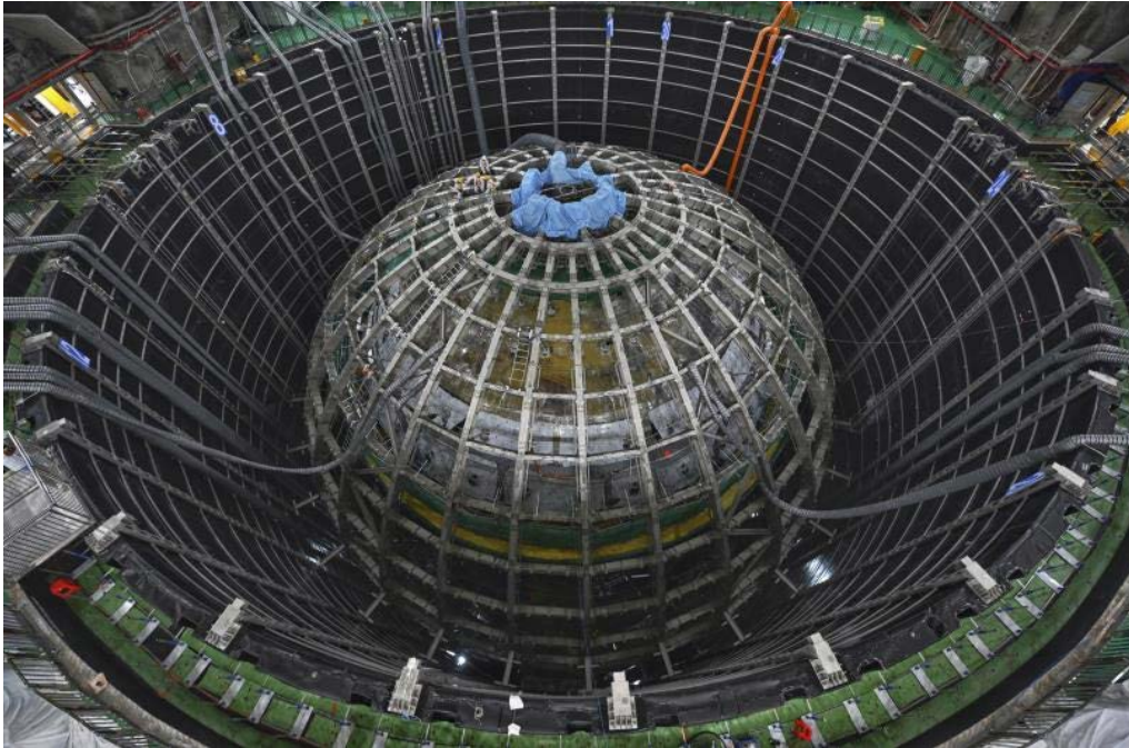
Рис. 17. Текущее состояние сборки детектора JUNO
