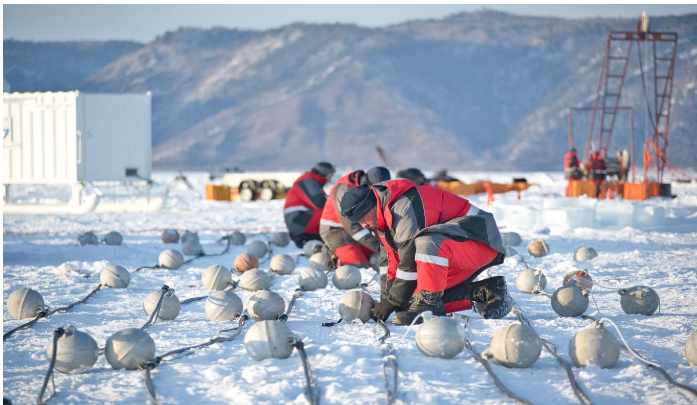
Рис. 12. Сборка гирлянды кластера установки Baikal-GVD
